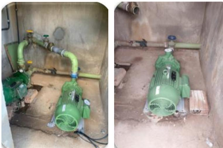
Figura 78 – Nova bomba instalada na EAT Belvedere
