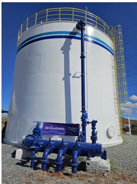
**Figura 89 – Reservatório de 800 mil litros colocado em operação no Morada do Vale**
