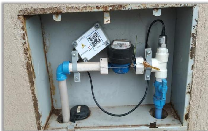
**Figura 49 - Instalação de data loggers no sistema de abastecimento para monitoramento de pressão**
