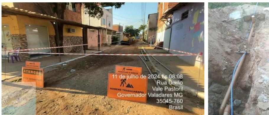
Figura 2 - Obras de implantação de rede de água e esgoto no Vale Pastoril IV
