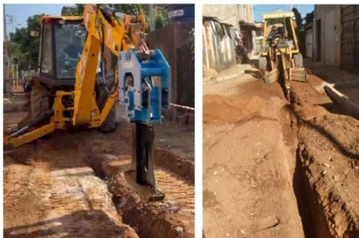
**Figura 4 – Obras de implantação de rede de água e esgoto no Vale Pastoril IV**
