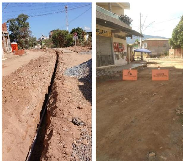
Figura 3 - Obras de implantação de rede de água e esgoto no Vale Pastoril IV
