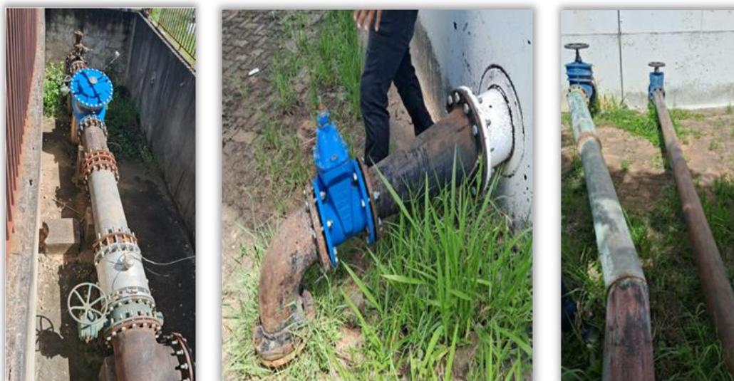
**Figura 84 – Implantação da setorização do sistema de abastecimento de água**
